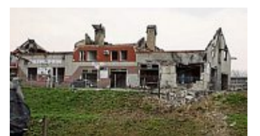
Zerstörtes Haus an einer Bahnstrecke in Lviv. Foto: Wagner
