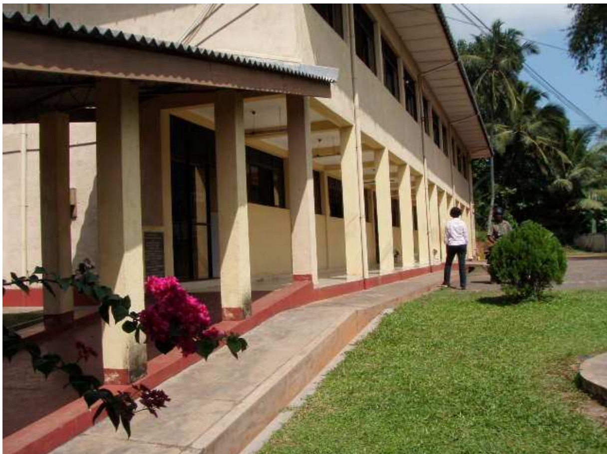
die Lieferanschrift: neu erbautes Krankenhaus in Gampaha (Minuwangoda)
